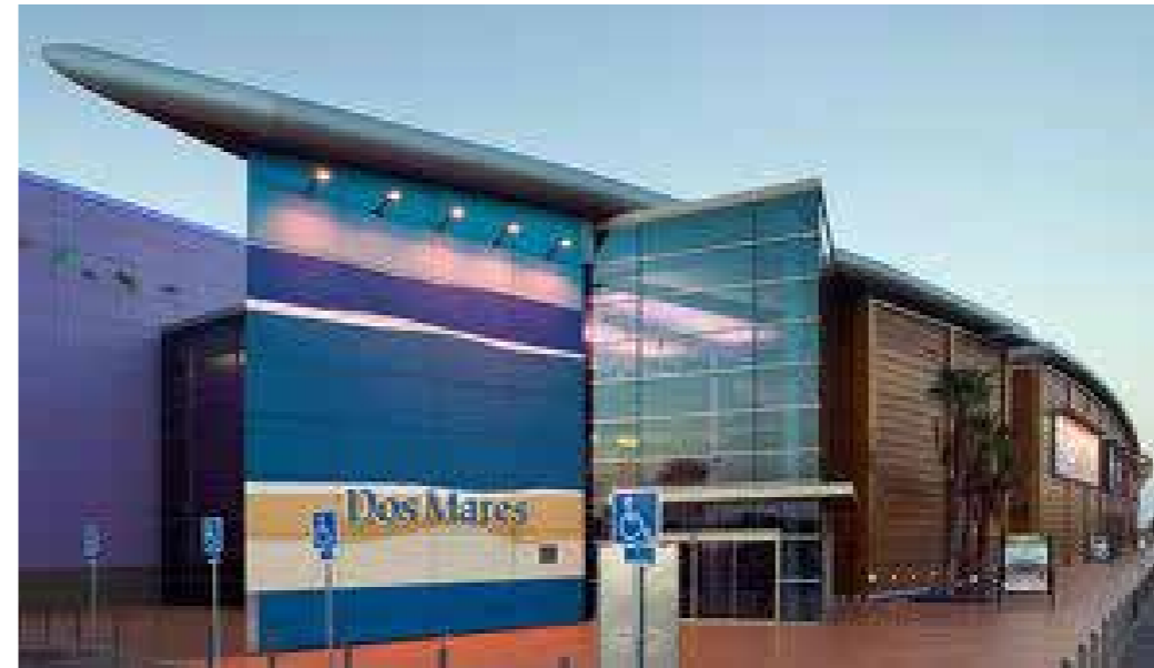
APLACADO DE HORMIGÓN IMPRESO
