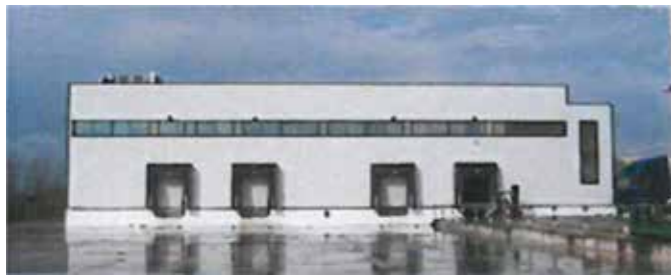
FACHADA RECEPCIÓN DE CAMIONES
